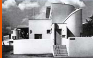
Hans Scharoun, Einfamilienhaus, 1927
